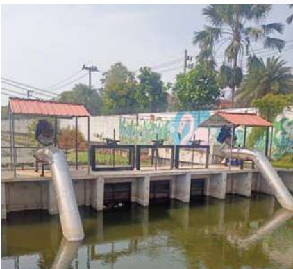
โครงการก่อสร้างประตูน้ำ พร้อมเครื่องสูบน้ำบริเวณปากซอยกรมส้ม ๑๐
