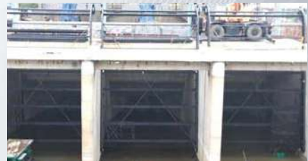
โครงการก่อสร้างประตูระบายน้ำคลองระบายนน้ำ D8 (หัวพระคีอ) ระยะที่ 2 จ.ขอนแก่น
