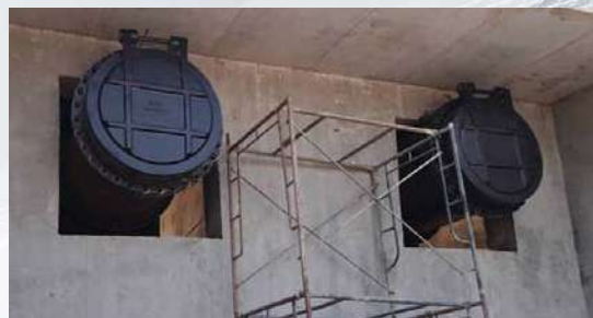
โครงการก่อสร้างประตูประมาศน้ำ และสถานีสูบน้ำกลางคลองท่าวาสายลำ
